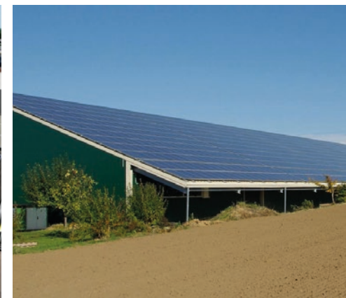
Zonnepanelen op schuin dak mogelijk.
