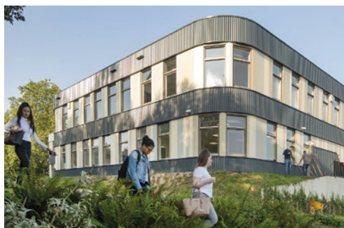
Afgeronde hoeken onderwijsgebouw
