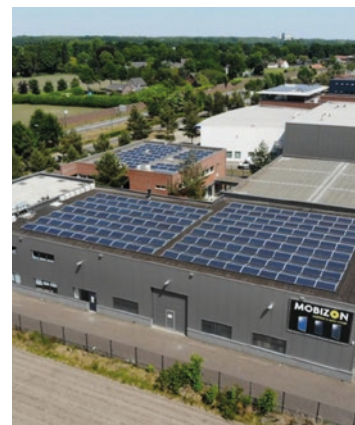
Zonnepanelen gericht op het zuiden.
