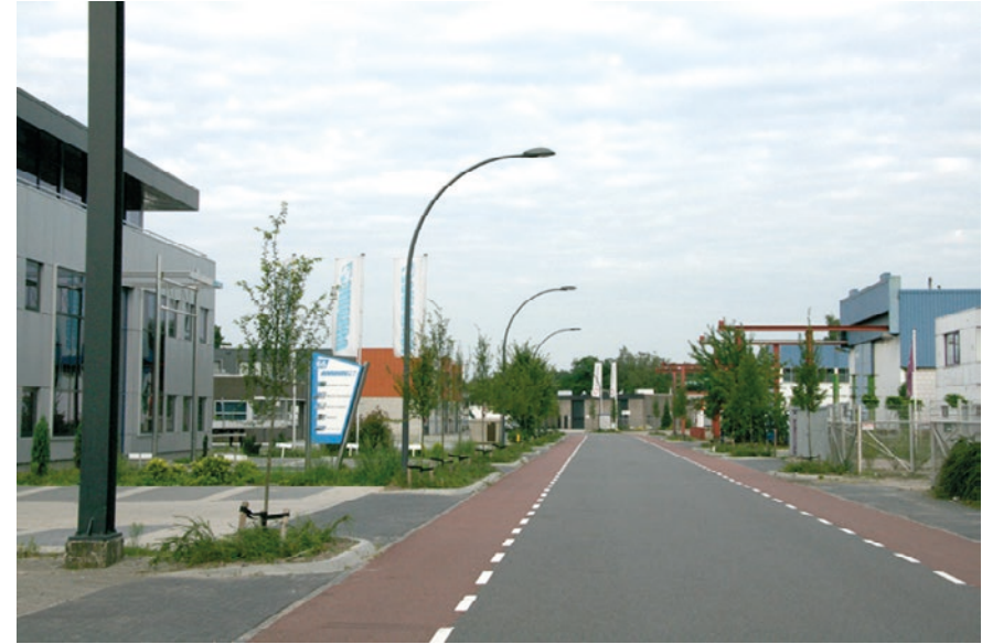
Laanprofiel met asfalt verharding en fietstrook op de rijbaan. (Feithenhof Nunspeet)
