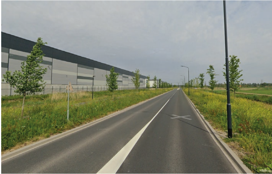
Laanprofiel met asfalt verharding en vrijliggend fietspad. Groene buffer tussen bebouwing. (Dortse Kil 4 - Dordrecht)
